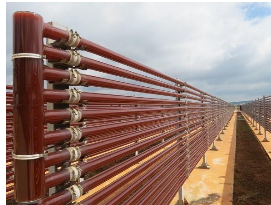
Una farm produttrice di H. pluvialis con un sistema di fotobioreattori tubulari situata in China (Algix)
